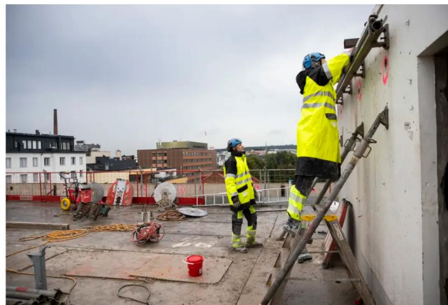
Purkutyöntekijät Valtteri Häkkänen (tikkailla) ja Jerome Hyytiäinen valmistelevat sahaa, jonka avulla betonirakenteet irrotetaan muista rakenteista. KUVA: SAARA TUOMINEN/ AAMULEHTI
